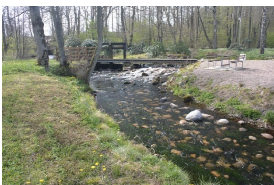
Figur 9. Genom att sänka av ett annat dämme vid Dämmemölla leds vattnet och fisken istället förbi det svårforcerade dämnet.
