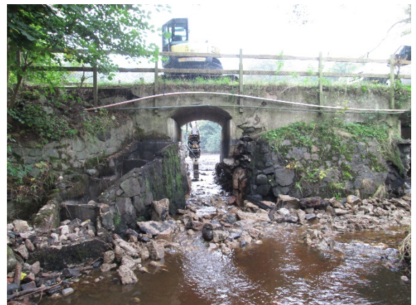
Figur 2. Hösten 2017 sänktes dammen av och fria vandringsvägar skapades. Den före detta fisktrappan syns till vänster i bild.
